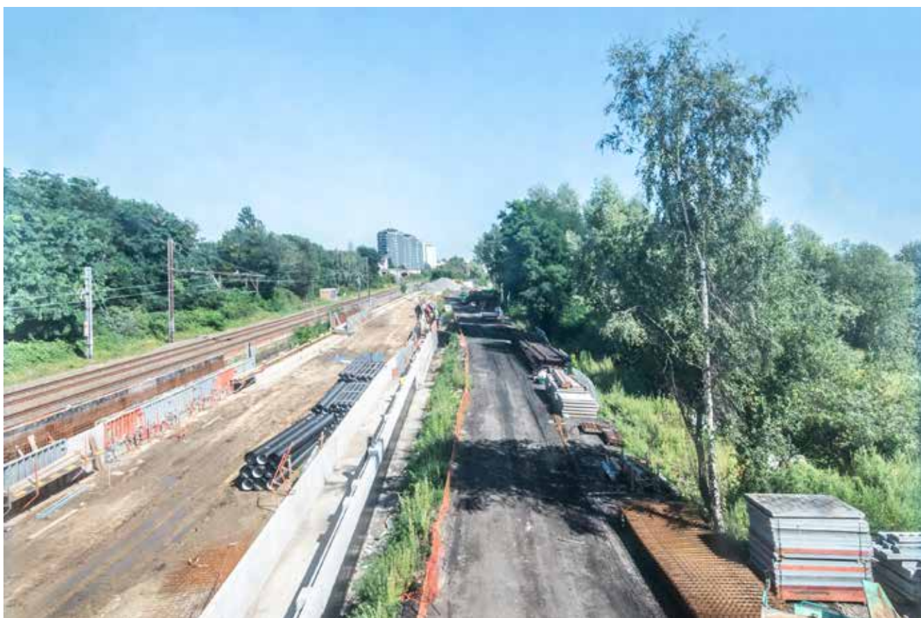
↑ Chantier du remisage métro de la STIB
